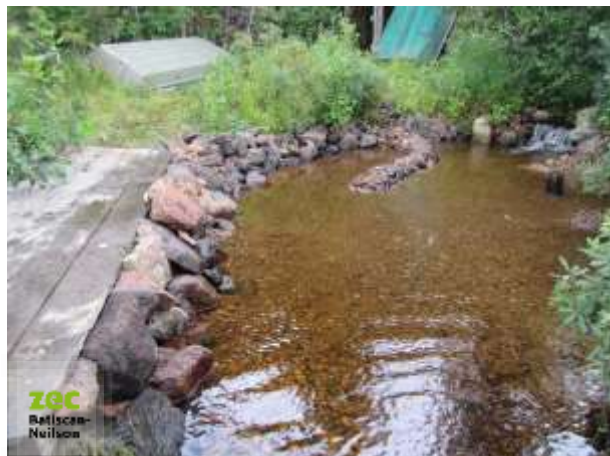
Figure 2. Entretien réalisé au lac Petit Alexandre dans le tributaire en provenance du lac Alexandre (mètres 6 à 11, vue de l'aval)
