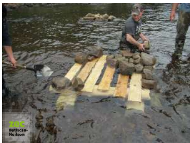
Figure 4. Abri en construction à l'émissaire du lac Picard
